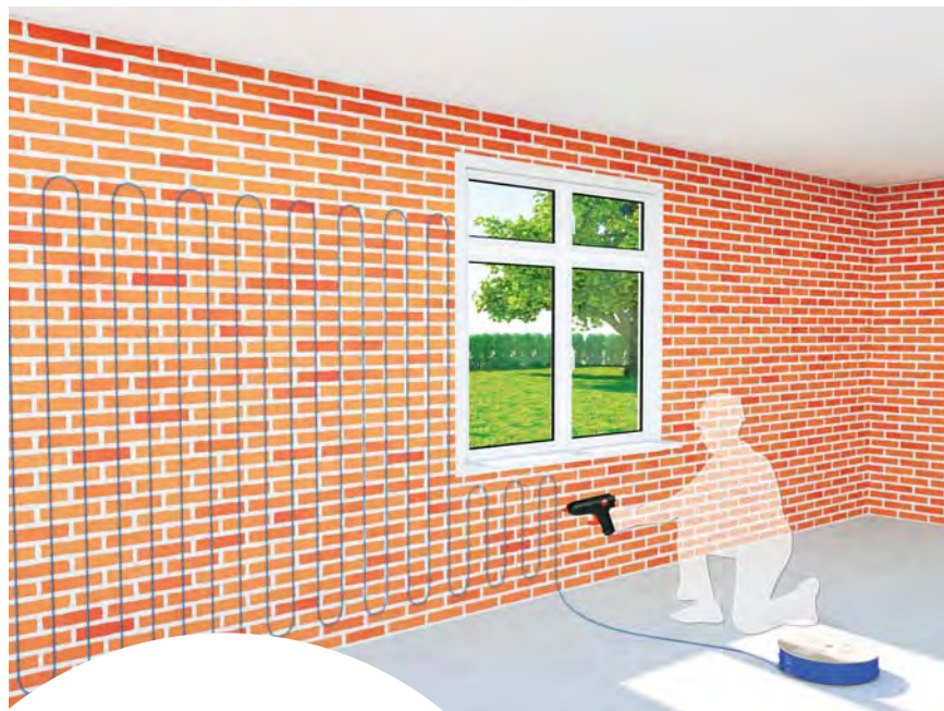
Фиксация нагревательного кабеля ELEKTRA горячим клеем
