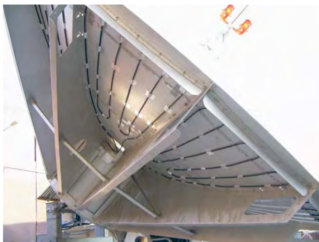
Защита от обледенения чаши спутниковой антенны
