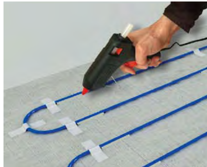
Установка нагревательного кабеля ELEKTRA DM горячим клеем
