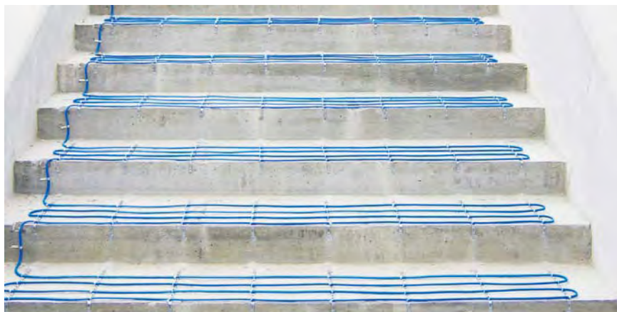
Расположение нагревательных кабелей
