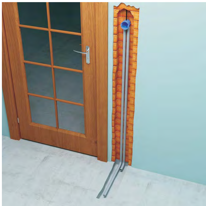
Монтаж гофрированных труб
